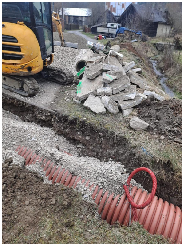
Výmena priepustovej kanalizačnej rúry.
